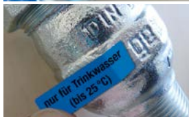
Bild 5: Zum Schluss unbedingt den kleinen blauen Aufkleber mit der Aufschrift "nur für Trinkwasser (bis 25°C)" auf die Verschraubung kleben. So können Sie noch nach Jahren nachvollziehen, dass Sie rechtzeitig das richtige Material verbaut haben.
