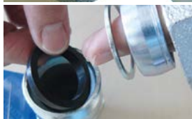
Bild 4: Vorlegering auflegen, Klemmring auflegen, Konusmutter aufschrauben
