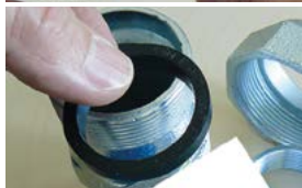
Bild 3: Den neuen EPDM Dichtring aus der Verpackung nehmen und in die Dichtkammer einlegen.
